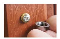
② 電動インパクトドライバーで木ねじを外し、縦柱を外します。側板の両端の縦柱が外れますと、側板が外れます。側板が外れますと、保温プレートが中柱にはまっているので手前に外します。
