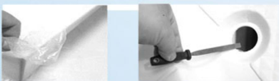
4) 排水栓リップ金属面に写真の様にコーティングを塗布します。
